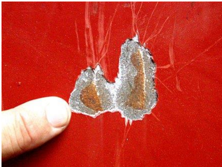
شکل ۲-۴: تخریب پوشش بواسطه جدایش کاتدی
