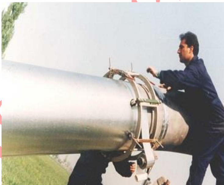
شکل ۱-۹- دستگاه نوارپیچ نیمه اتوماتیک
