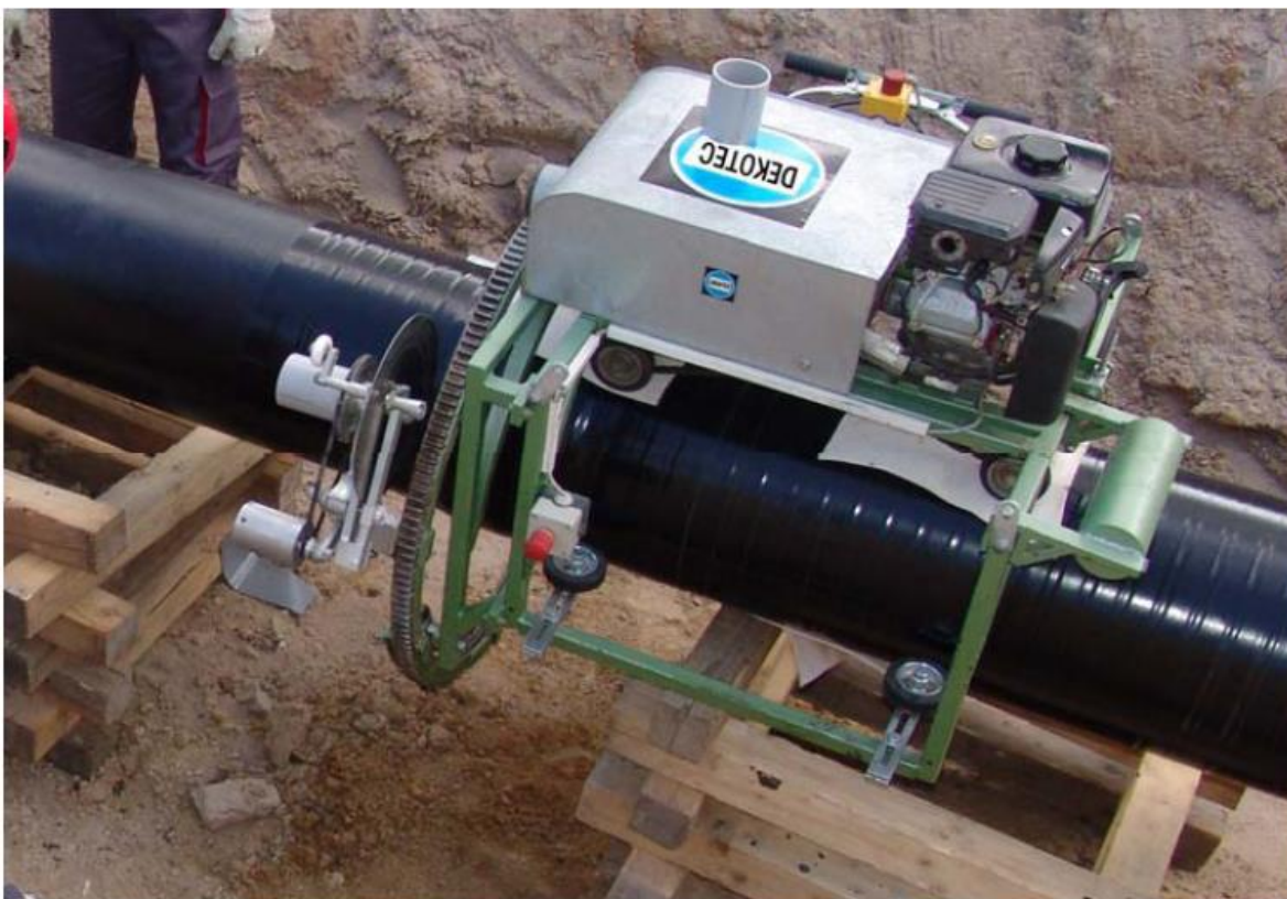
شکل ۱-۱۱- دستگاه نوارپیچ اتوماتیک
