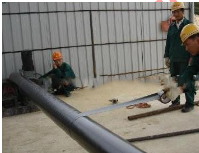
شکل ۱-۸- روش دستی نوارپیچی خط لوله
