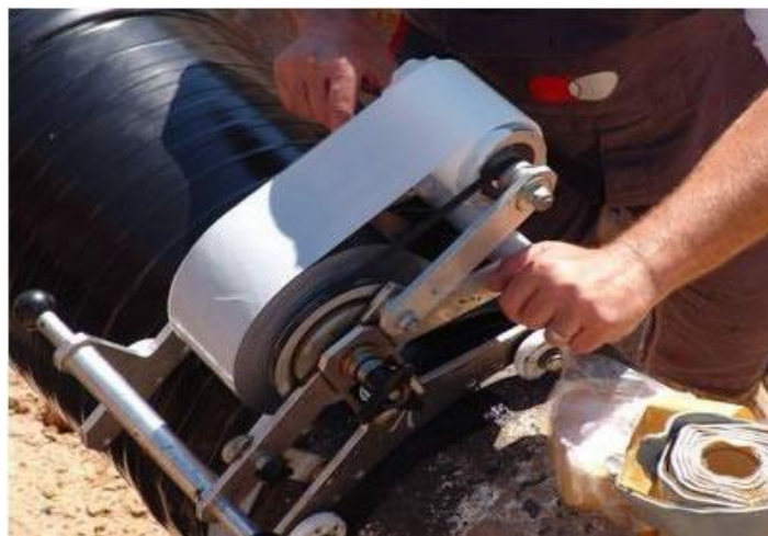
شکل ۱-۱۰-۱- دستگاه نوارپیچ نیمه اتوماتیک کوچک
