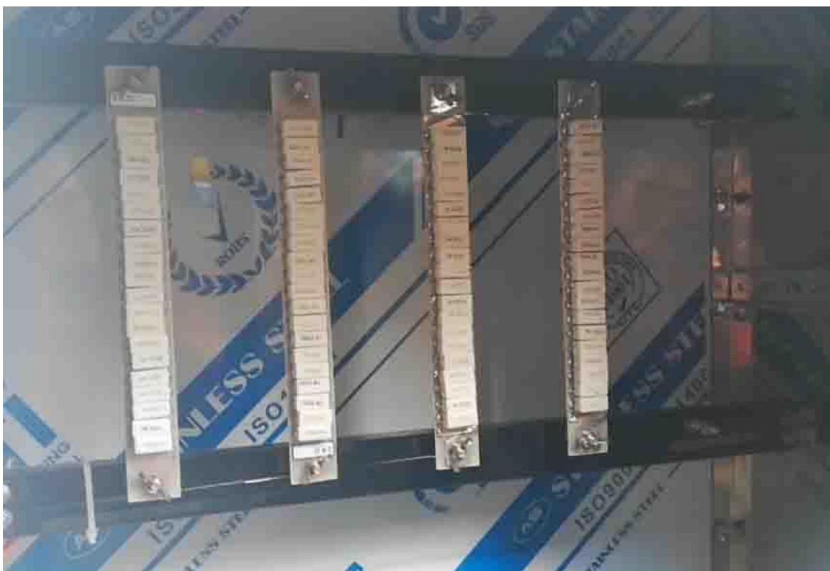
شکل ۷. نحوه نصب رزیستور
