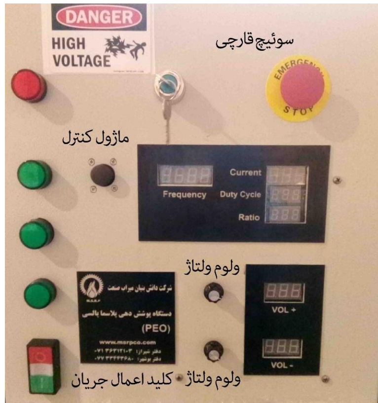
شکل ۲. کلیدهای کنترل کننده دستگاه
